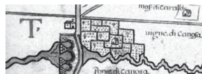
Fig. 3 - Ponte romano sull'Ofanto, inizio e termine della DOP "Castel del Monte". In primo piano le "Vigne di Canosa". Particolare della mappa del 1686 della Regia Dogana della Mena delle pecore di Foggia, disegnata dagli agrimensori Antonio e Nunzio Michele.
